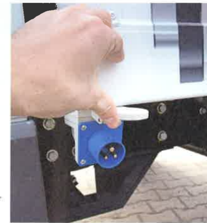
Die Akkus der Kühlmaschine laden über Nacht
